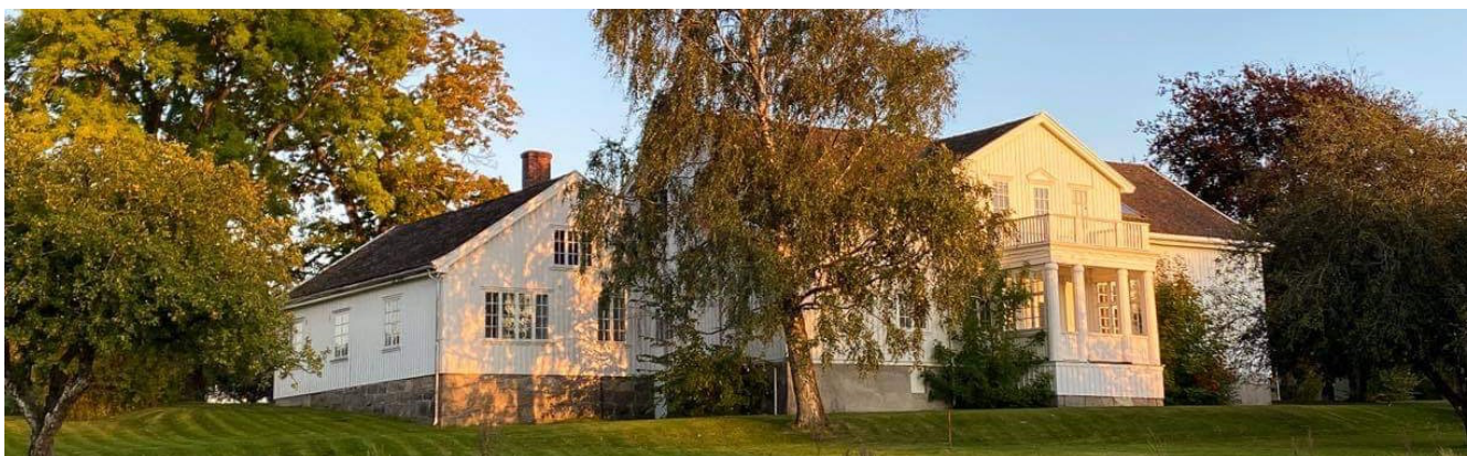
Sanita-bygget (Veum Allé 1) er godkjent omregulert til åtte nye leiligheter.
